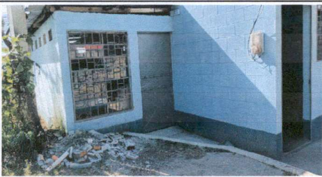
Foto 3: Sustitucion de vidrios quebrados en el área de cocina, dirección del establecimiento y 4 aulas.
