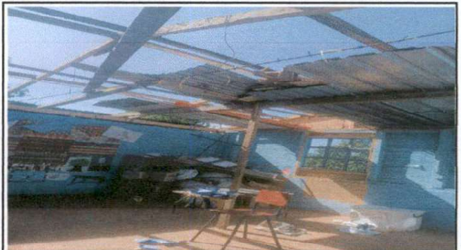
Foto 2: Sustitucion de lamina por lamina troquelada aluzinc calibre 26, en el tercer aula del módulo de primaria.
