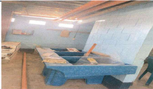
Foto1: Compra e instalación de pila en el área de la cocina.
