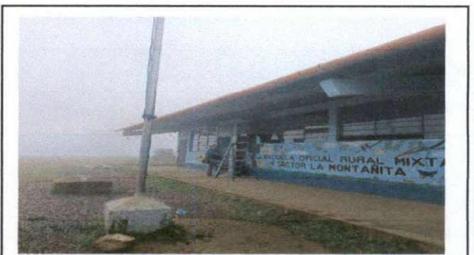
Foto 6: Sustitucion de lamparas en tres aulas y el corredor del establecimiento.
